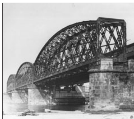
oben: Erweiterungsbau der Brückenpfeiler für das zweite Gleis 1892
